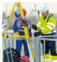
Arbeiten in engen Räumen: Gut vorbereitet eine sichere Angelegenheit.
